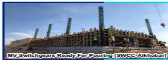
MV Switchgears Ready For Pouring (SWCC-Alkhubar)
